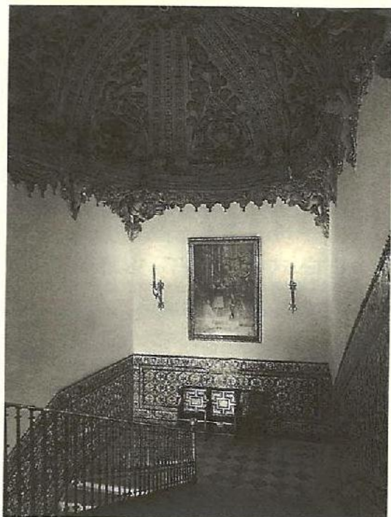
Bóveda de la escalera principal.
